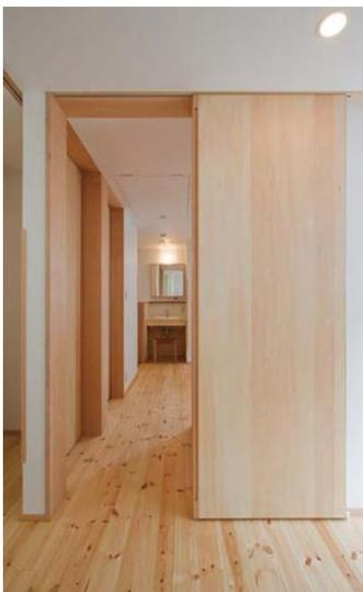
内部建具の吊戸、吊金具は天井と同面の鴨居に納める。
