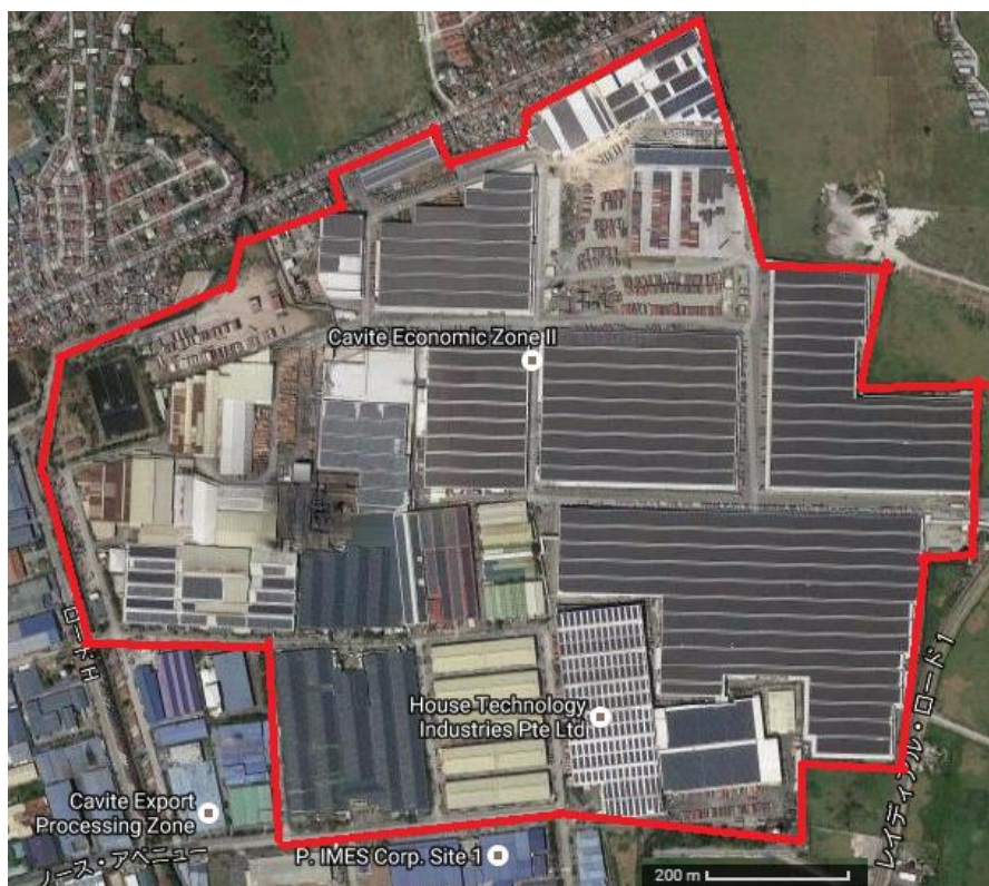
工場の屋根にはソーラーパネル
