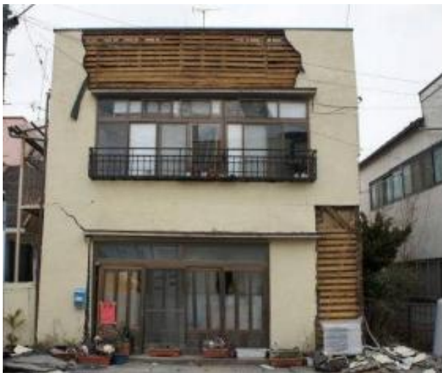
応急危険度“危険”判定の店舗併用住宅 栃木県那須町豊原乙の被害
