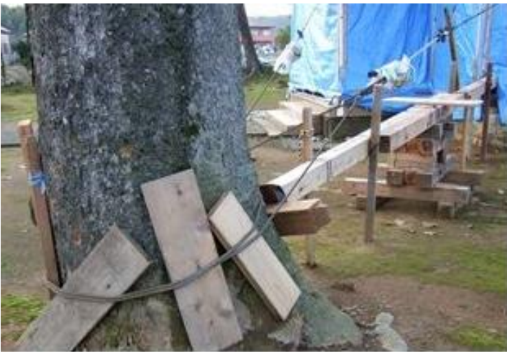
傾いた建物の柱脚足元を押さえ込み、柱頭接合部からワイヤーで引き寄せる
