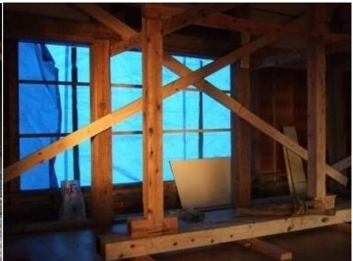
傾いた建物の柱脚足元を押さえ込み、柱頭接合部からワイヤーで引き寄せる
