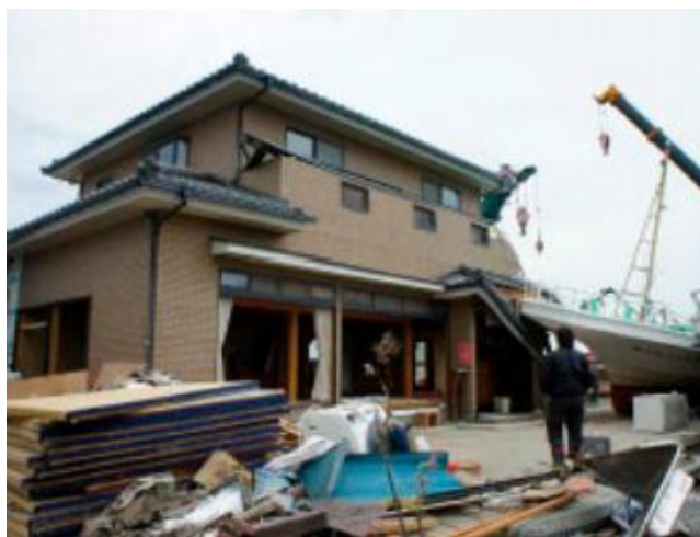
写真 3.3-10 津波の作用方向に開口部が多く、残存したと考えられる木造住宅 (宮城県仙台市若林区)
