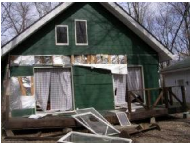
大きく傾斜した木造
