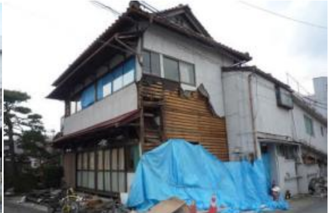
部分的に崩壊した木造
