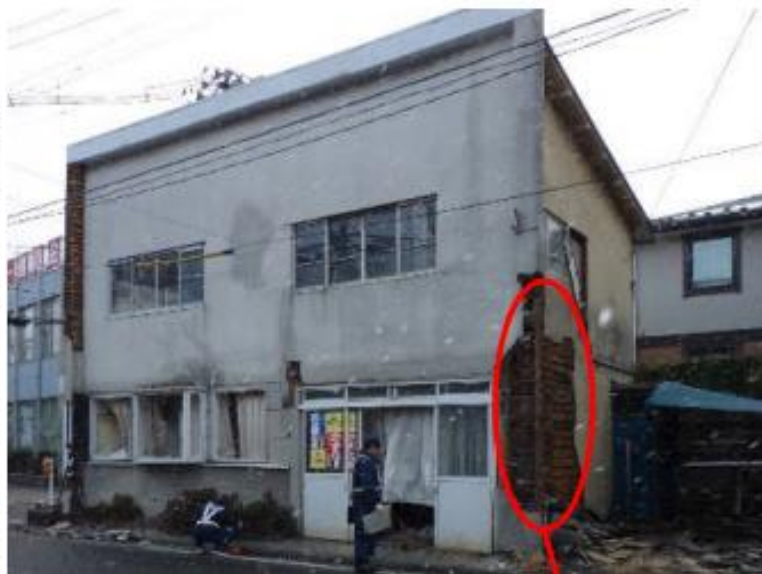
モルタル外壁の剥落 木ずり下地が生物劣化
