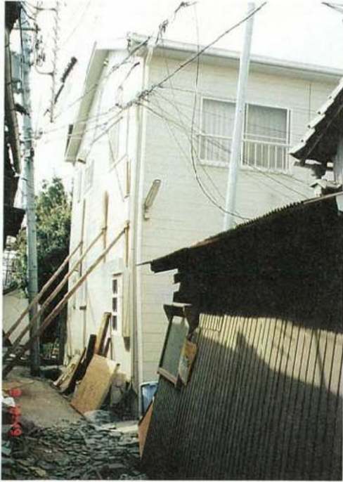
写真3.2.3.7 〔復旧事例、長田2〕被災後の状況（被害度Ⅳ）
