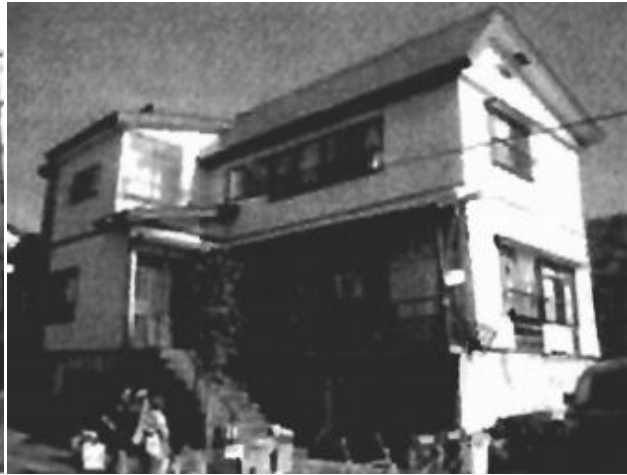
危険＝ 1 階傾斜大
