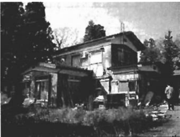
危険＝基礎の亀裂
