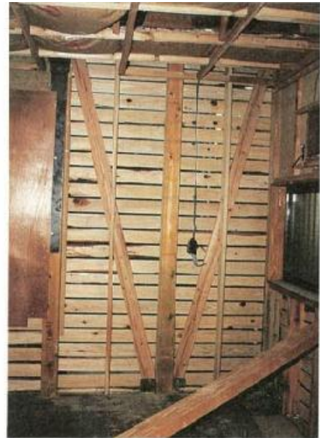
写真3.2.3.57 Y氏宅 東側外壁内側、土塗り壁の撤去、三つ割筋違いを二つ割筋違いに変更
