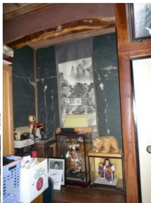
1 階：南へ 17/1000 \text{ rad} , 2 階：南へ 30/1000 \text{ rad} 傾斜 床の間のラスボードの目地にひび割れ
