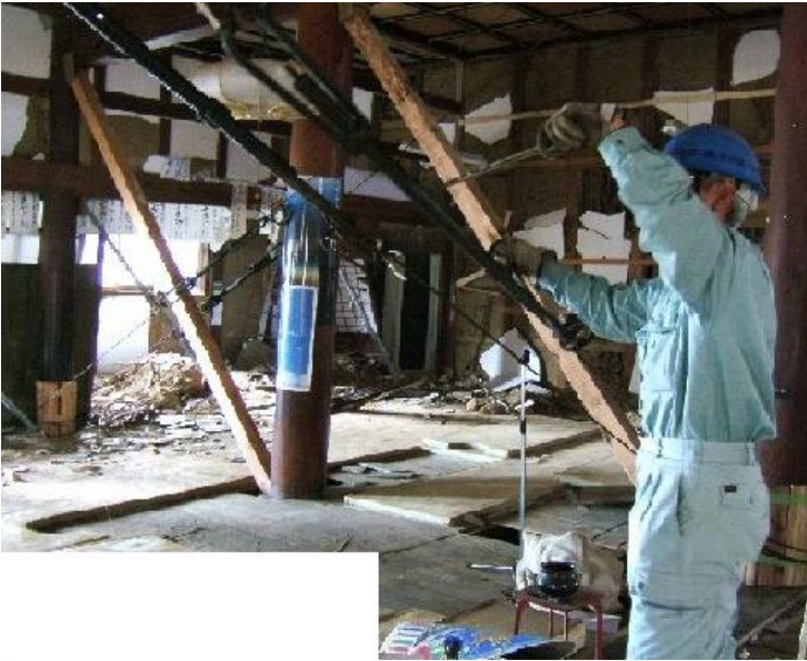
突っ張り&引っ張り補強
