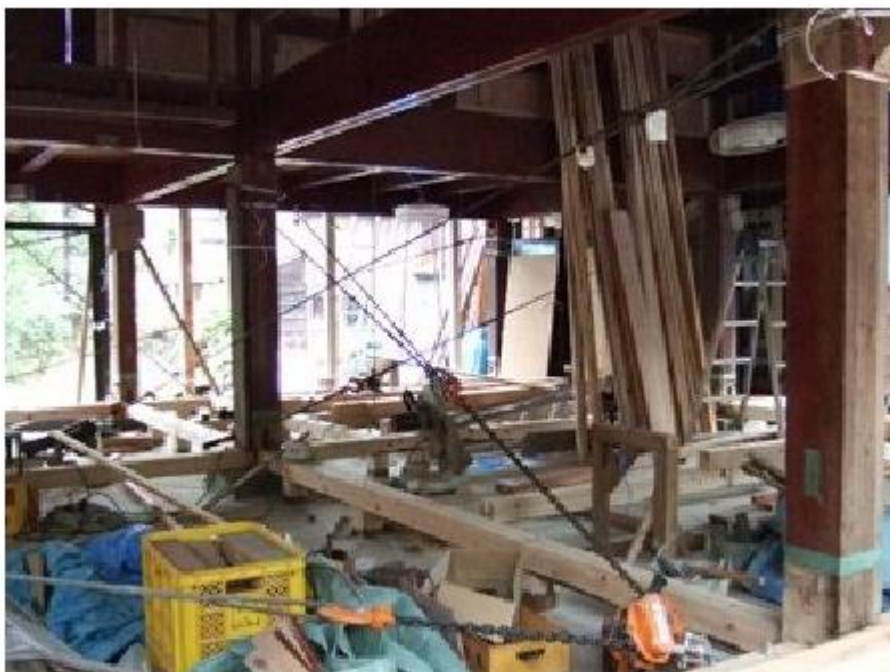
建物柱脚足元を転ばないように足固めのうえ補強
