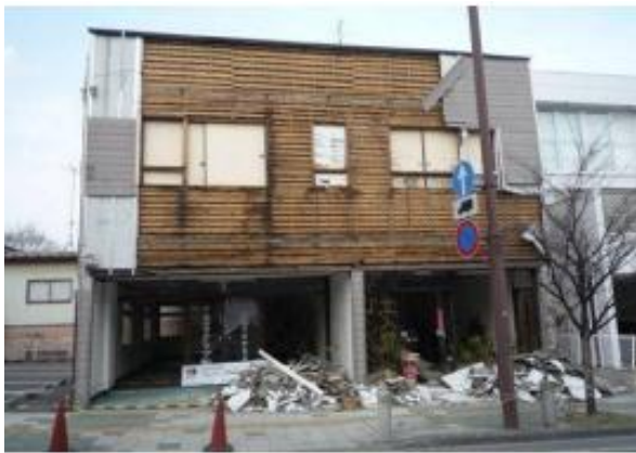
ほぼ全面的に外壁モルタルが剥落した店舗併用住宅 福島県須賀川市（加治町）の被害
