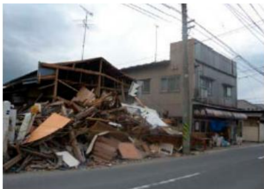
写真 3.3-5 地震により倒壊した住宅（宮城県）
