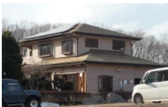
残留変形が残る木造住宅
