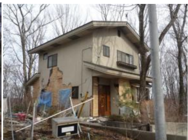
外壁モルタルの剥落
