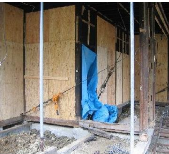
傾いた建物の柱脚足元を押さえ込み、柱頭接合部からワイヤーで引き寄せる
