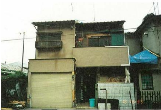
写真3.2.3.19 〔復旧事例、本山1〕 応急復旧した後の状況（1995年3月）
