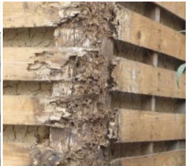
柱の腐朽とシロアリの食害
