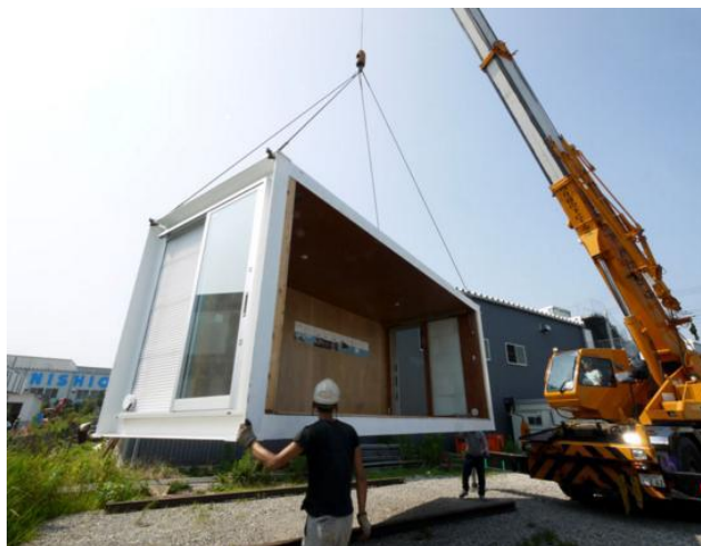
クレーン車で持ち上げられ設置。
